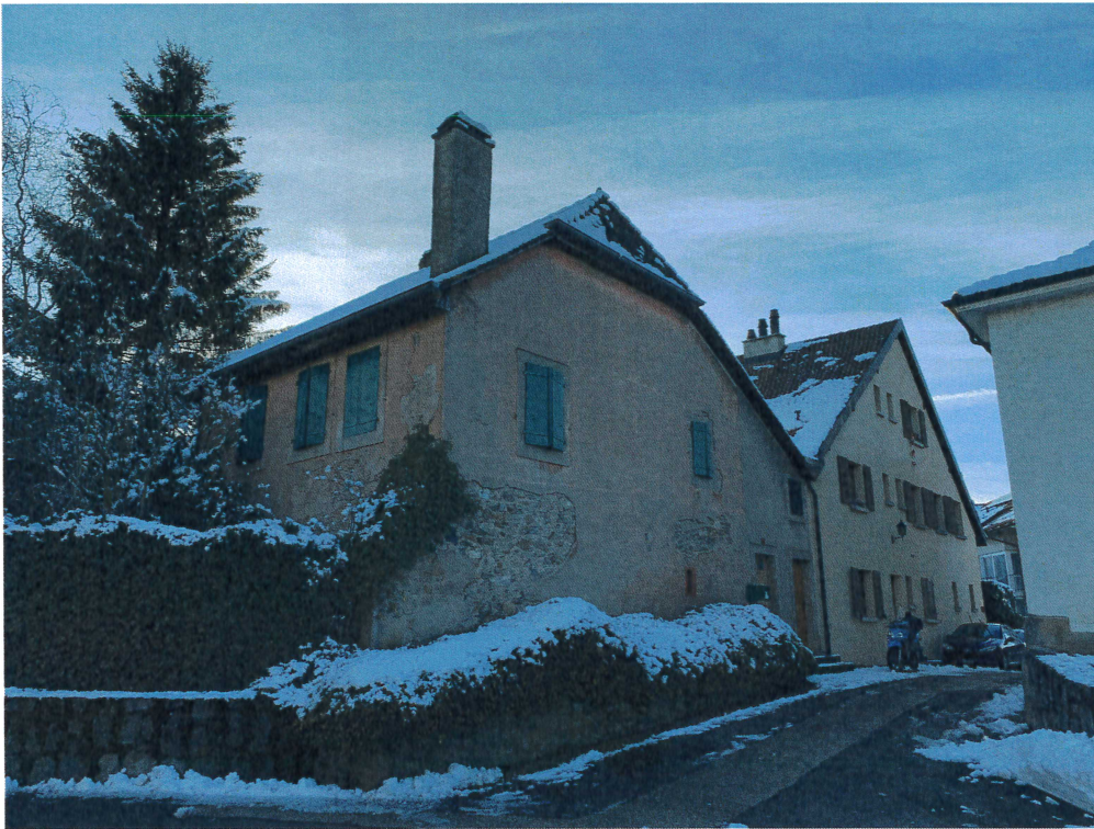
Maison d'habitation ECA 90 depuis la rue de l'Eglise
