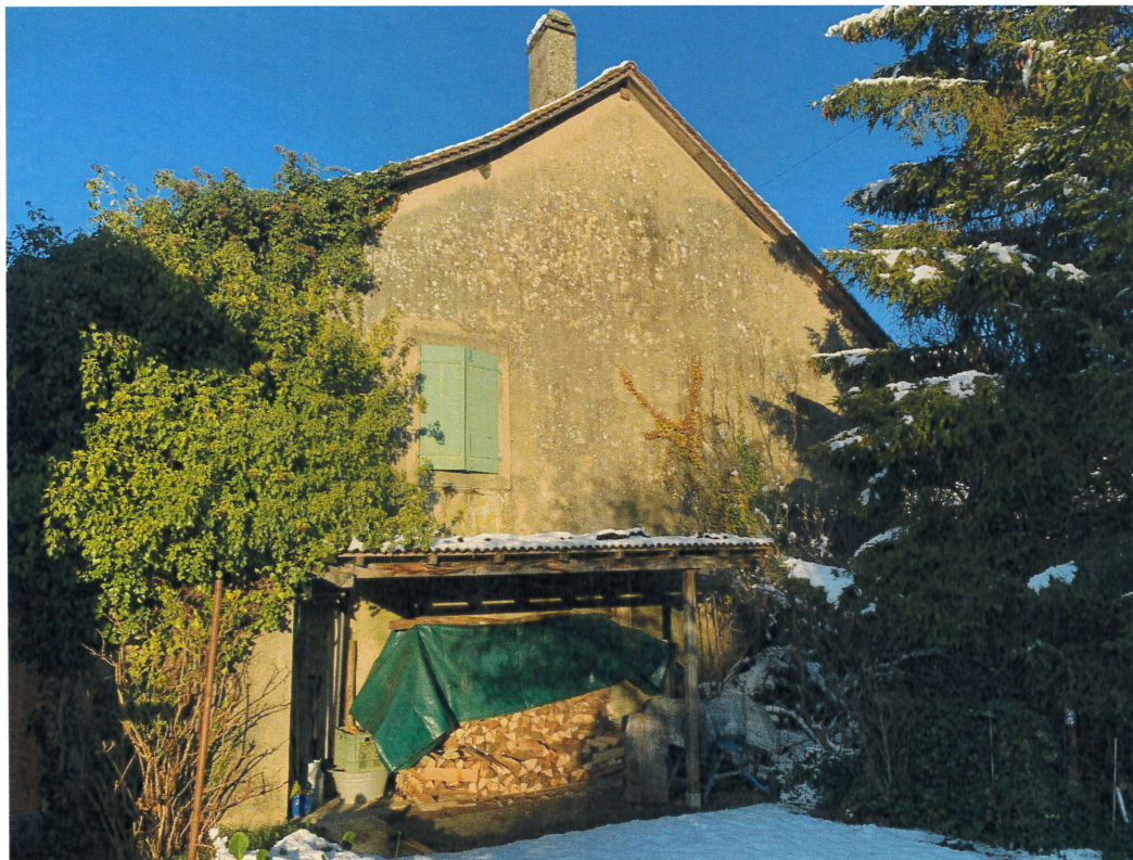
Maison d'habitation ECA 90 depuis le jardin (côté parking public)
