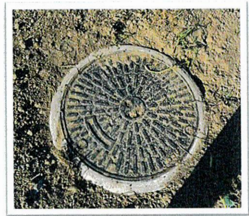
Chambre EC refaite avec réhausse et couvercle
