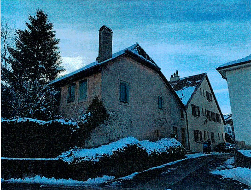
Maison Adamina depuis la rue de l'Eglise
