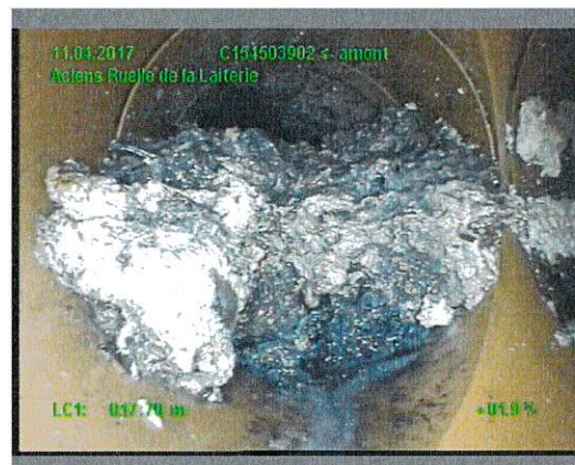
Figure 3: Branchement EU bouché à 80%
